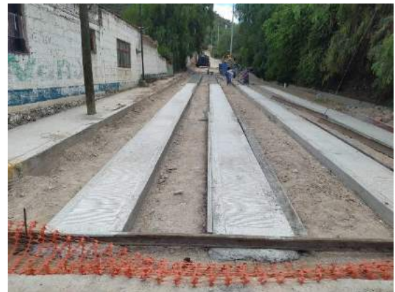
Imagen 24: Proceso de la construcción de pavimento con huellas de concreto hidráulico y empedrado asentado en seco en calle miguel hidalgo en la localidad de El Tandhe
