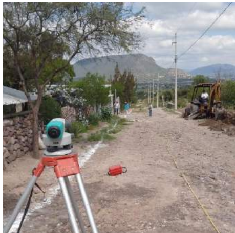
Imagen 49: Inicio de la construcción de guarniciones y banquetas en calle Pirules en la localidad de Huitexcalco Colonia.
