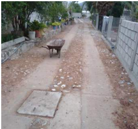
Imagen 7: Materiales de la construcción de huellas de concreto y empedrado en callejón del beso en la localidad de La Estancia
