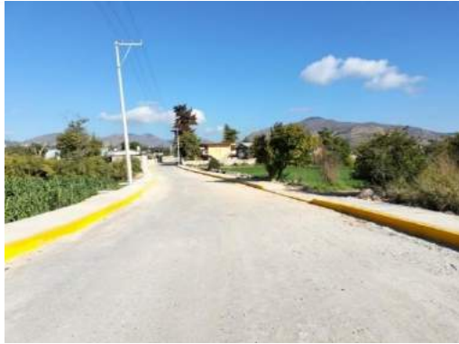
Imagen 47: Proceso de construcción de guarniciones y banquetas en calle Mauricio Muñoz Basilio en la localidad de El Dadho.
