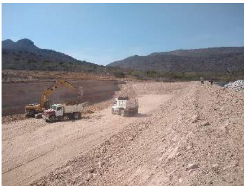
Imagen 37: Trabajos en la construcción de nueva celda para disposición de residuos sólidos 1era etapa.
