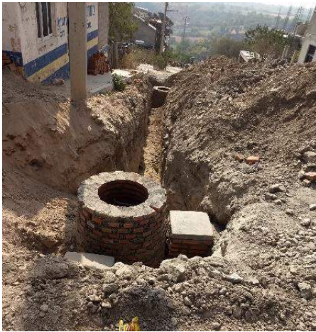
Imagen 35: Proceso de la construcción de drenaje sanitario en calle Melesio García en la localidad de Tunititlan
