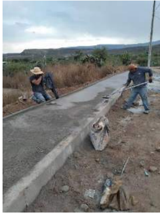
Imagen 51: Trabajos en la construcción de guarniciones y banquetas en calle La Palma en la localidad de el Llano Primero
