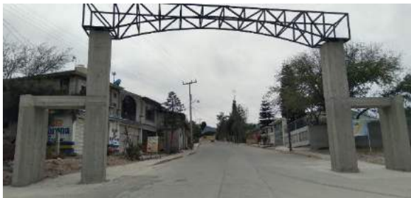
Imagen 53: Construcción de Pórtico en acceso de la comunidad de Xothi 1era etapa.
