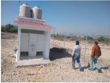
Imagen 45: Trabajos en la construcción de plataforma y obras complementarias en la localidad de La Estancia municipio de Chilcuautla hidalgo
