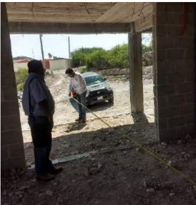
Imagen 33: Trabajos en la construcción de centro de desarrollo comunitario segunda etapa en la localidad de La Loma
