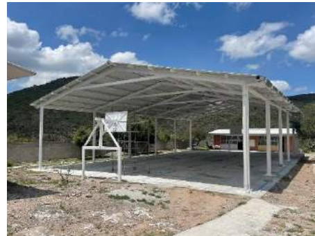
Imagen 30: Construcción de techado en área de impartición de educación física en escuela primaria bilingüe Quetzalcoatl C.C.T. 13DPB0739E en la localidad de Cerro del Corazón segunda etapa.
