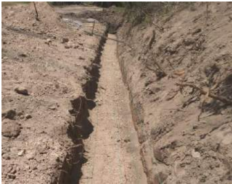
Imagen 63: Trabajos en la construcción de la planta de tratamiento de aguas residuales para beneficiar a la localidad de Zacualoya en el municipio de Chilcuautla
