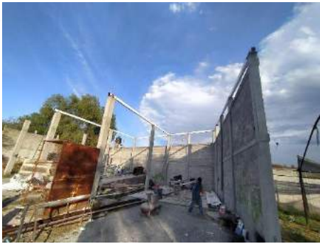
Imagen 39: Trabajos en la construcción de anexo en instalaciones del ayuntamiento en la localidad de Chilcuautila, del municipio de Chilcuautila, Hidalgo.
