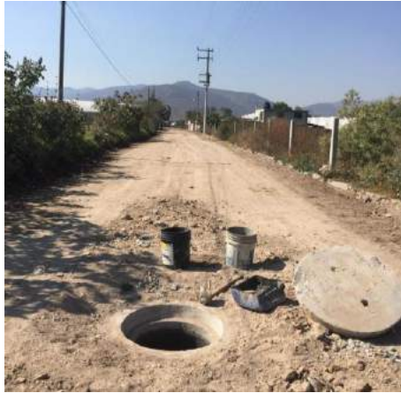
Imagen 55: Trabajos en la construcción de red de drenaje sanitario en la localidad de la estancia, municipio de Chilcuautla, Hgo. (etapa 1 de 5)
