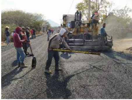
Imagen 27: Proceso en la pavimentación asfáltica en calle Independencia en la localidad de Texcatepec
