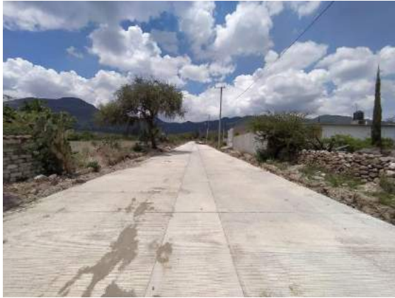
Imagen 13: construcción de pavimento hidráulico de calle José María Morelos en la localidad de Huitexcalco de Morelos
