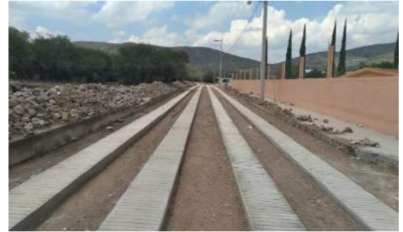
Imagen 22: construcción de huellas de concreto hidráulico y empedrado en av. Benito Juárez en la localidad colonia Benito Juárez
