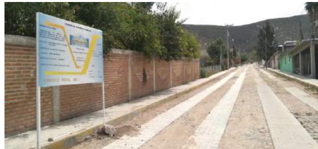
Imagen 12: Mampara informativa de la construcción de huellas de concreto hidráulico en calle Luis Donaldo Colosio en manzana Santa Rita en la localidad Santa Ana Batha
