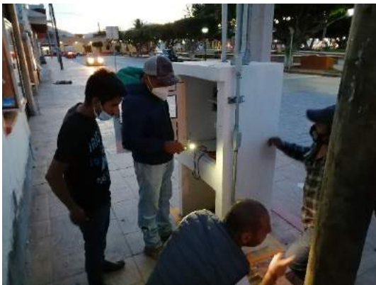
Imagen 41: Trabajos en la rehabilitación del sistema de alumbrado público en el cuadro principal
