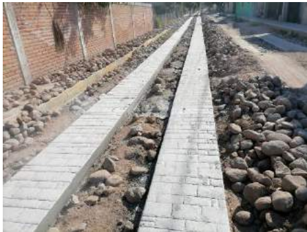
Imagen 11: Proceso de la construcción de huellas de concreto hidráulico en calle Luis Donaldo Colosio en manzana Santa Rita en la localidad Santa Ana Batha
