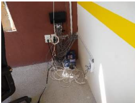
Imagen 43: Rehabilitación de red de internet en las instalaciones de la presidencia municipal
