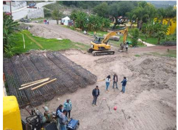
Imagen 66: Habilitado de acero para columnas del puente vehicular Tlacotalpilco
