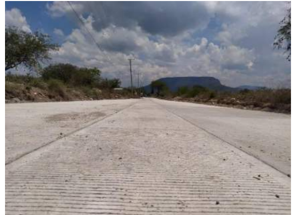
Imagen 14: construcción de pavimento hidráulico de calle José María Morelos en la localidad de Huitexcalco de Morelos
