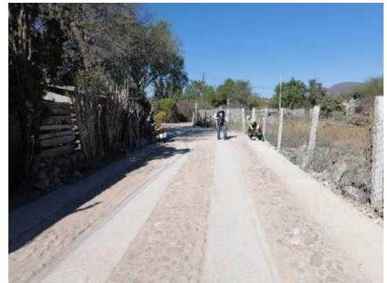
Imagen 6: Proceso en la construcción de avimentación hidráulica y empedrado en varias calles en la localidad El Xothi
