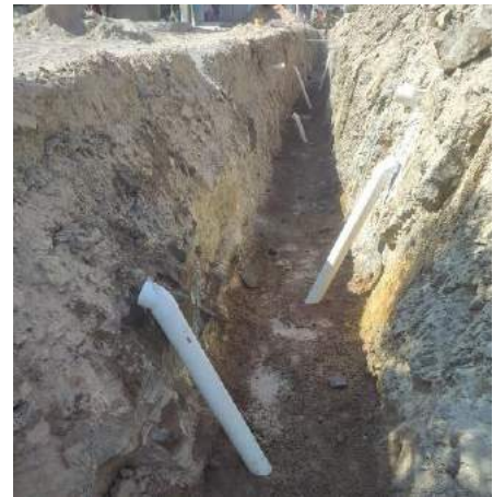
Imagen 36: Trabajos en la construcción de drenaje sanitario en calle Melesio García en la localidad de Tunititlan
