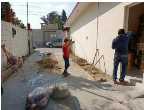
Imagen 31: Trabajos en la adecuación de sala covid en centro de salud Chilcuautila en la localidad de Chilcuautila, del municipio de Chilcuautila, Hidalgo
