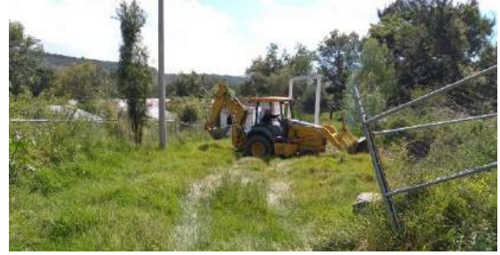
Imagen 62: Trabajos en la rehabilitación del sistema de agua potable en la localidad de Tlacotlapilco.
