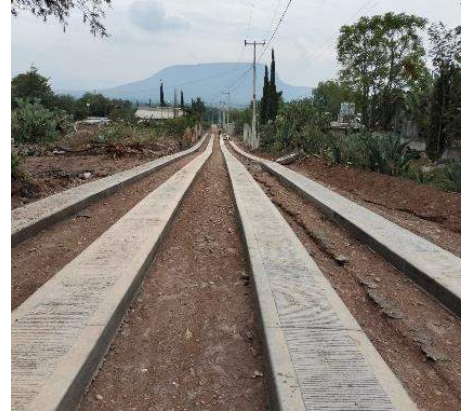
Imagen 18: Construcción de pavimento con huellas de concreto hidráulico y empedrado asentado en seco en calle 2 de noviembre y 3 de mayo en la localidad de Huitexcalco Colonia
