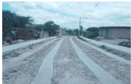
Imagen 2: Construcción de pavimentación hidráulica y empedrado en calle San Nicolas en la localidad Huitexcalco de Morelos
