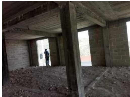
Imagen 34: Proceso de la construcción de centro de desarrollo comunitario segunda etapa en la localidad de La Loma
