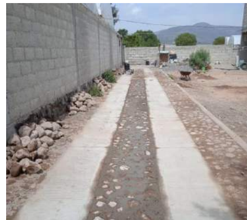
Imagen 8: Proceso de la construcción de huellas de concreto y empedrado en callejón del beso en la localidad de La Estancia
