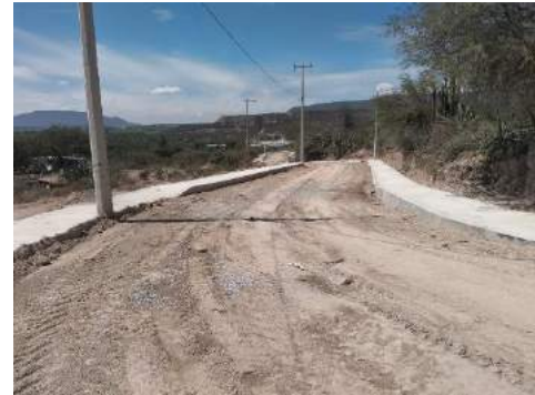
Imagen 52: Construcción de guarniciones y banquetas en calle La Palma en la localidad de el Llano Primero
