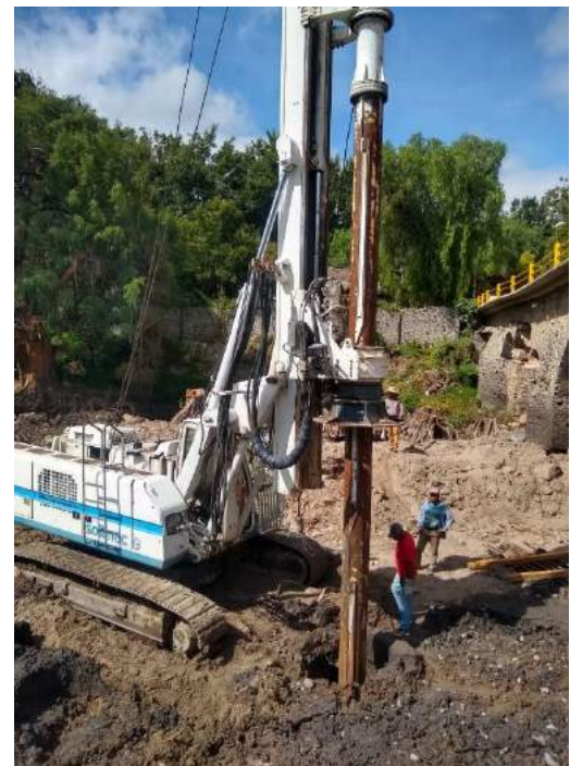
Imagen 68: Perforación para piloteo de columnas en el puente vehicular Tlacotalpilco.
