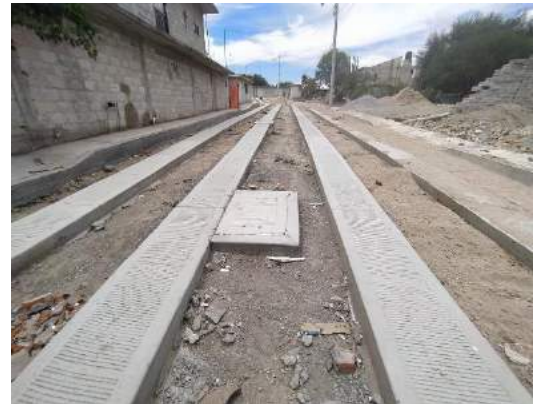
Imagen 20: Proceso de la construcción de pavimento con huellas de concreto hidráulico y empedrado asentado en seco en calle Los Pirules en la localidad de El Cerrito
