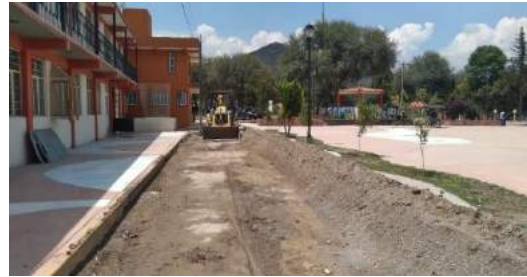
Imagen 26: Trabajos en la construcción de pavimento hidráulico en callejón central en la localidad de Santa Ana Batha
