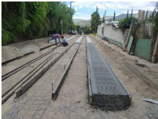
Imagen 23: Trabajos en la construcción de pavimento con huellas de concreto hidráulico y empedrado asentado en seco en calle miguel hidalgo en la localidad de El Tandhe
