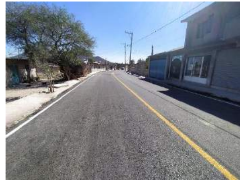
Imagen 28: Término de los trabajos en la pavimentación asfáltica en calle Independencia en la localidad de Texcatepec
