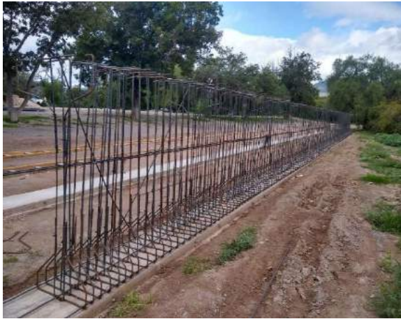
Imagen 65: Armado de traves tipo Ashtho para el puente vehicular de Tlacotalpilco.
