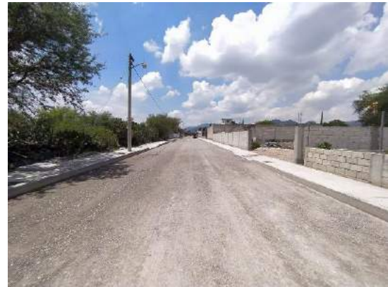
Imagen 16: Construcción de pavimento asfáltico en calle 15 de abril en la localidad de Texcatepec
