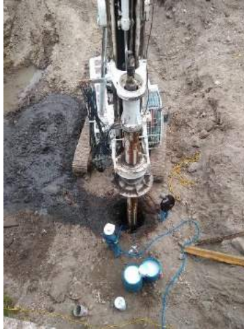
Imagen 69: Perforación para piloteo de columnas en el puente vehicular Tlacotalpilco.
