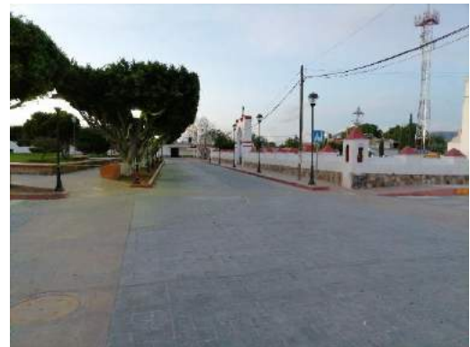
Imagen 42: Rehabilitación del sistema de alumbrado público en el cuadro principal
