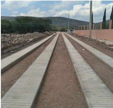
Imagen 21: construcción de huellas de concreto hidráulico y empedrado en av. Benito Juárez en la localidad colonia Benito Juárez
