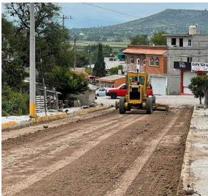
Imagen 9: Proceso en la construcción de pavimentación hidráulica en calle Aldama del cadenamiento 0+196.00 al 0+219.31.00 en la localidad de Tunititlan
