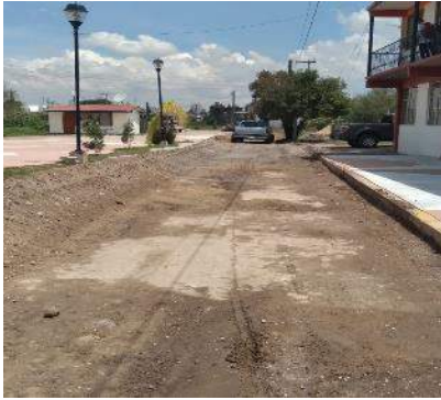
Imagen 25: Proceso de la construcción de pavimento hidráulico en callejón central en la localidad de Santa Ana Batha
