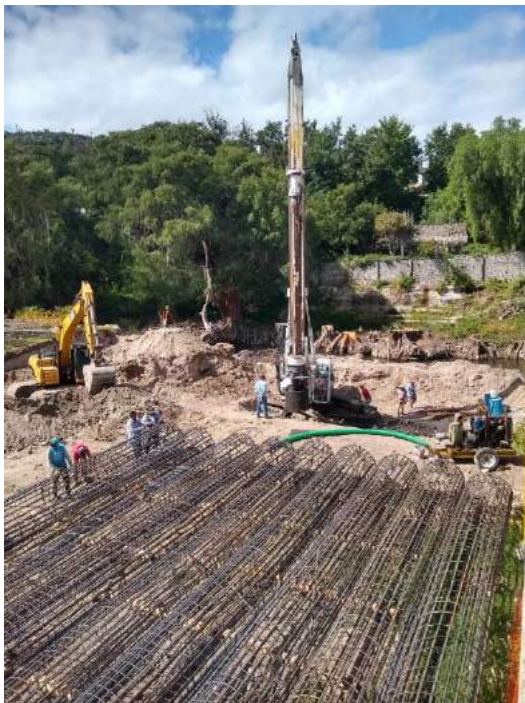
Imagen 67: Habilitado de acero para columnas del puente vehicular Tlacotalpilco
