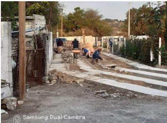
Imagen 5: Trabajos en la construcción de pavimentación hidráulica y empedrado en varias calles en la localidad El Xothi
